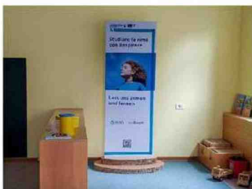
ANCHE IL RICORSO a sistemi di depurazione passivi (nella foto un totem rivestito con tessuto adsorbente) non ha fatto riscontrare miglioramenti della IAQ
